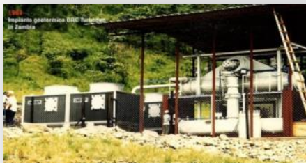
1988 – Impianto geotermico ORC da 200 kW el in Zambia
