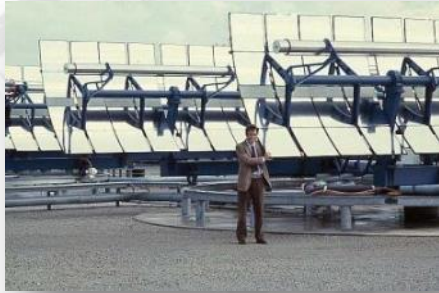
1984 – Turbogeneratore ORC 40 kW el per applicazione solare a Perth, Australia
