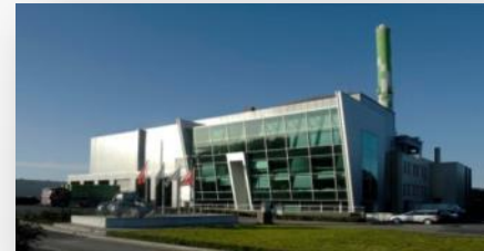
2008 – Turbogeneratore ORC per recupero calore da 3 MW, Belgio
